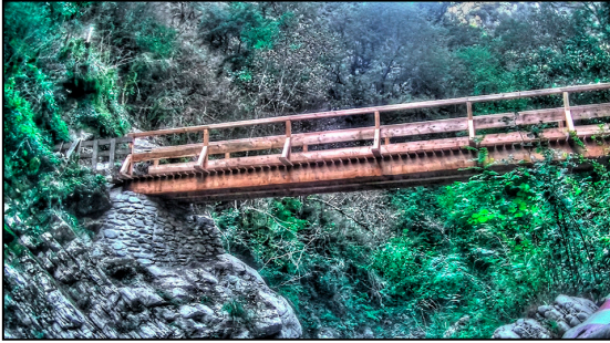
le pont de la Baragne. Inespéré !
